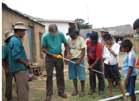
Técnico de F.A.I.R. Tinkuy entrena a la comunidad en aspectos de plomería.
